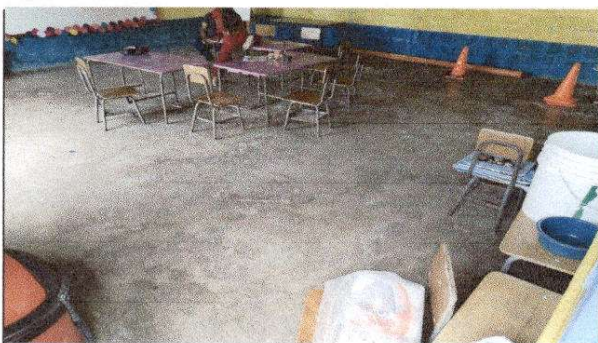
foto 3: Sustitución de piso de torta de concreto y sustitución de piso de cemento líquido
