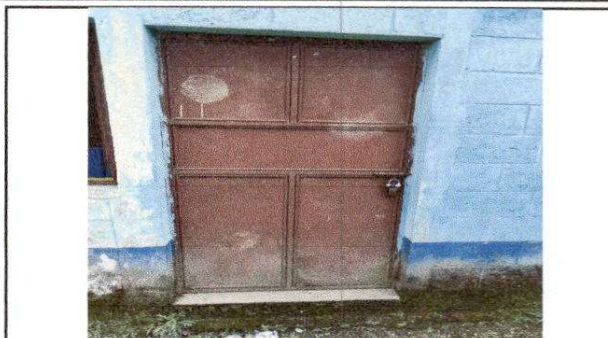
foto 8: Fabricación e instalación de puertas de metal en módulos
