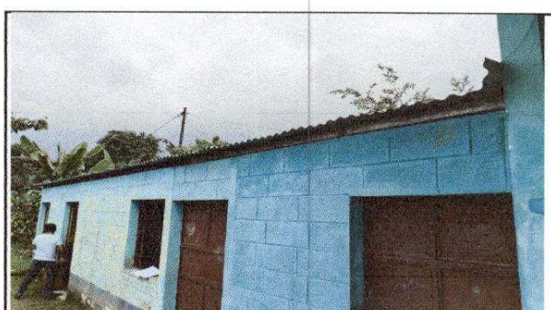
foto 4: Sustitución de canal de metal
