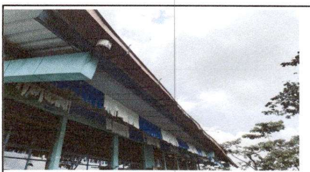
foto 10: Sustitución de canal de metal
