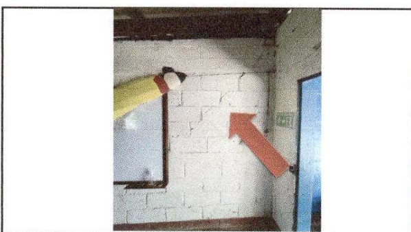
FOTO 5: Sellado de grietas y fisuras en muros
