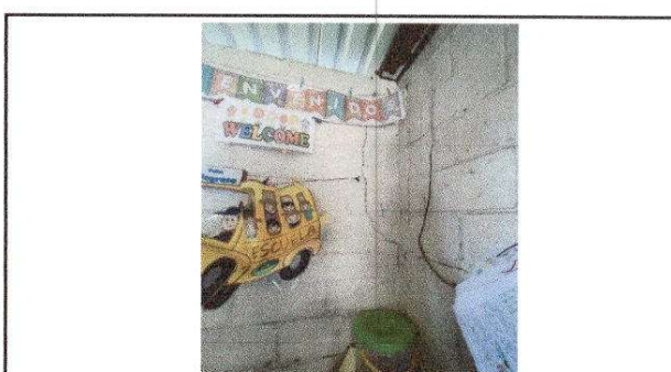
FOTO 6: Sellado de grietas y fisuras en muros
